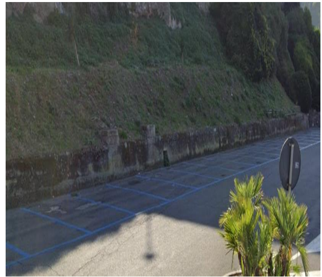
5 Public parking Via della Panoramica
